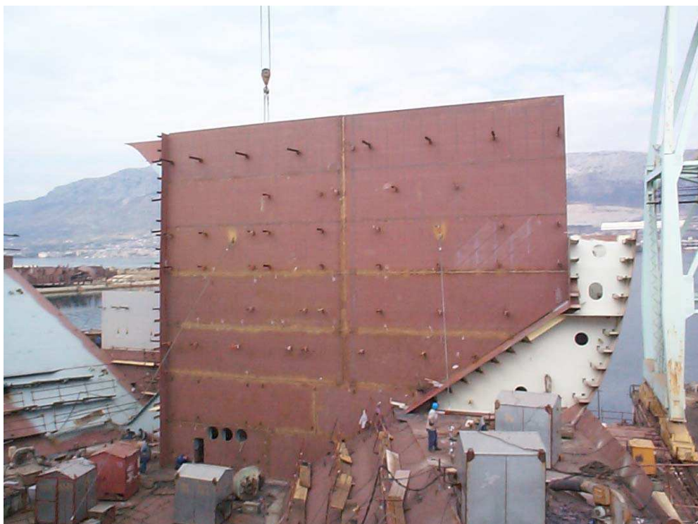
Slika : Ravna ukrepljena poprečna pregrada sa glatke strane (Izvor: Brodosplit – Brodogradilište d.o.o. Split)
