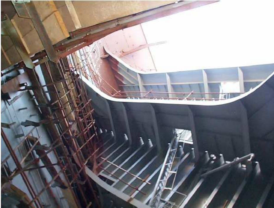
Slika : Poprečna pregrada (Izvor: Brodosplit – Brodogradilište d.o.o. Split)
