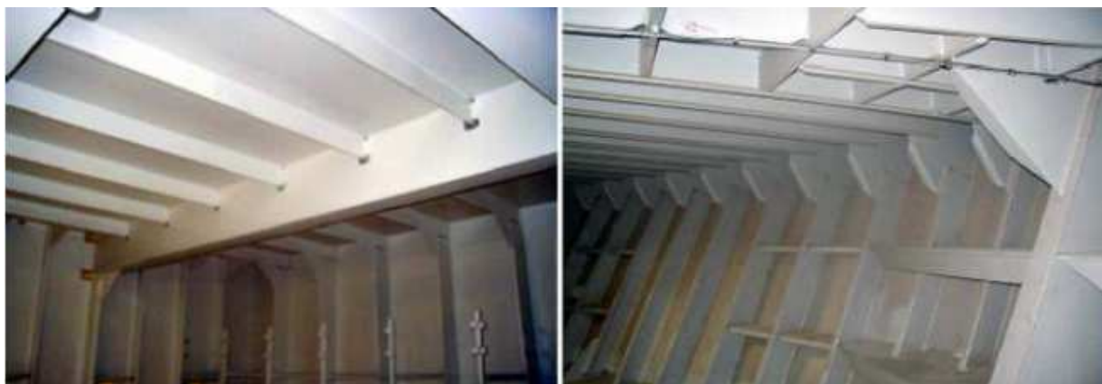
Slika : Sponje i podveze palube nadgrađa i bočne stjenke nadgrađa (Izvor: Brodosplit – Brodogradilište d.o.o. Split)
