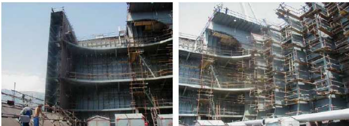
Slika : Nosači i ukrepe u tankovima (Izvor: Brodosplit – Brodogradilište d.o.o. Split)
