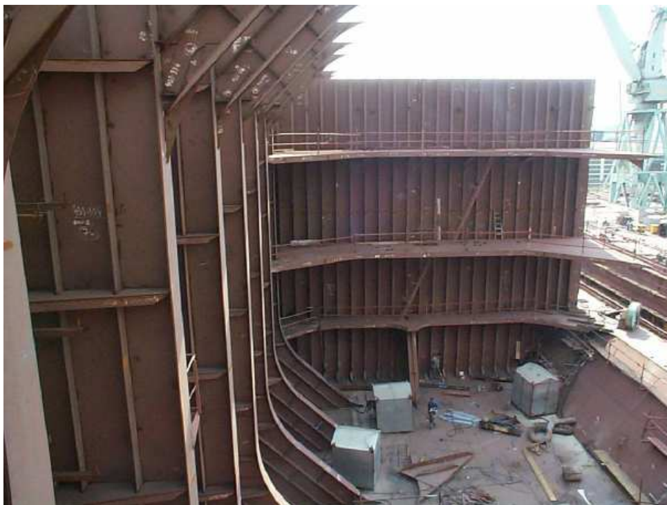
Slika : Poprečne i uzdužne pregrade (Izvor: Brodosplit – Brodogradilište d.o.o. Split)
