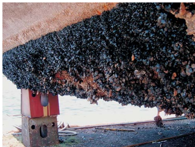
Slika 2 Obraštanje dna plutajuće platforme Figure 2 Fouled bottom of a floating platform
