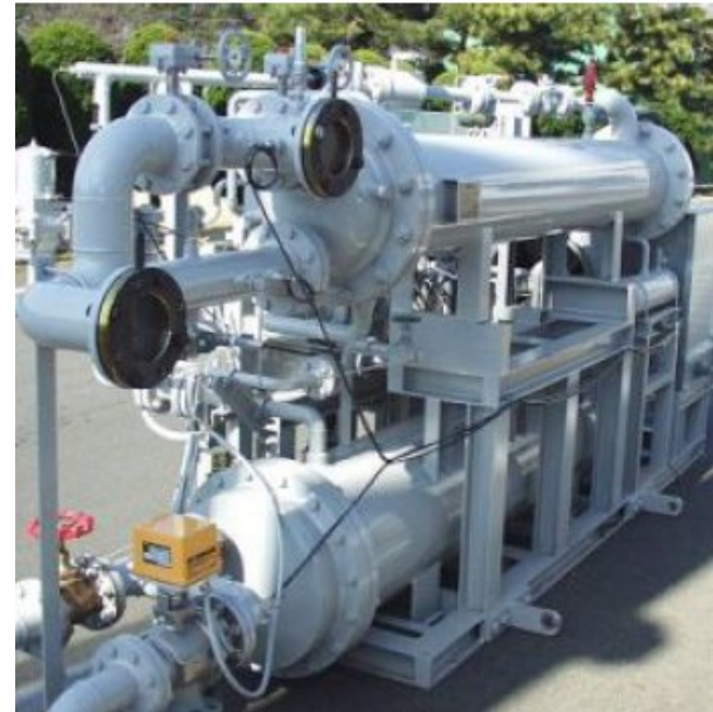
Mayekawa ejektorski rashladni uređaj pogonjen s MSUI.
