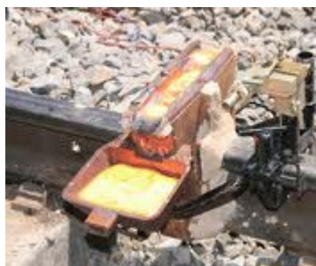
Aluminotermijsko zavarivanje
