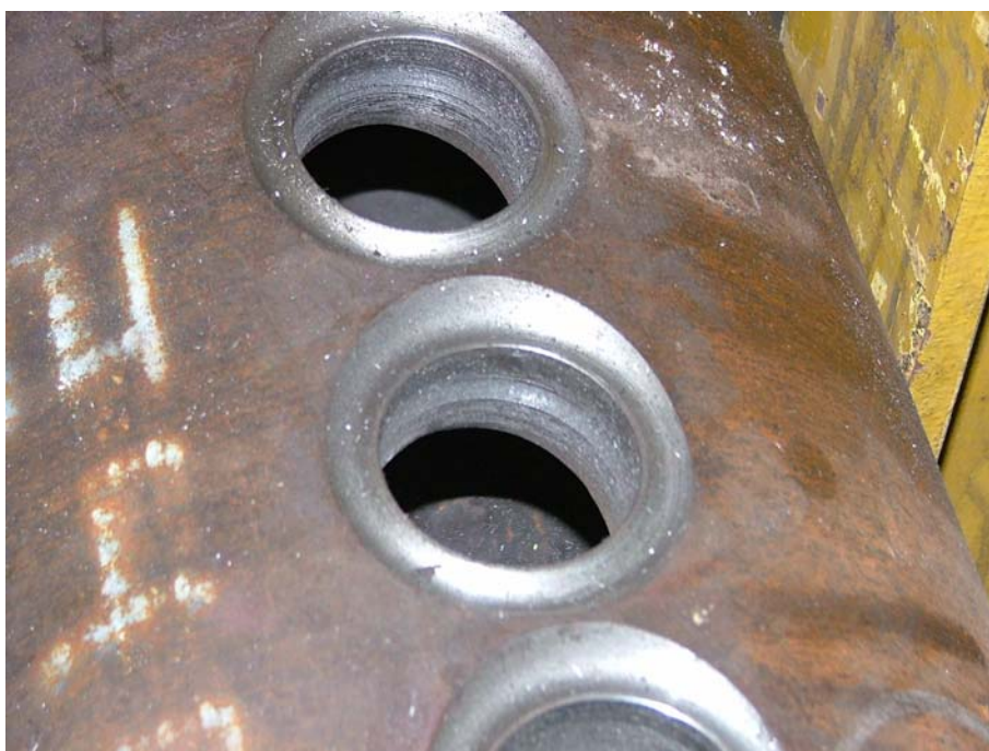
Slika 4.19 Pripremljeni žljebovi za zavarivanje na komori
