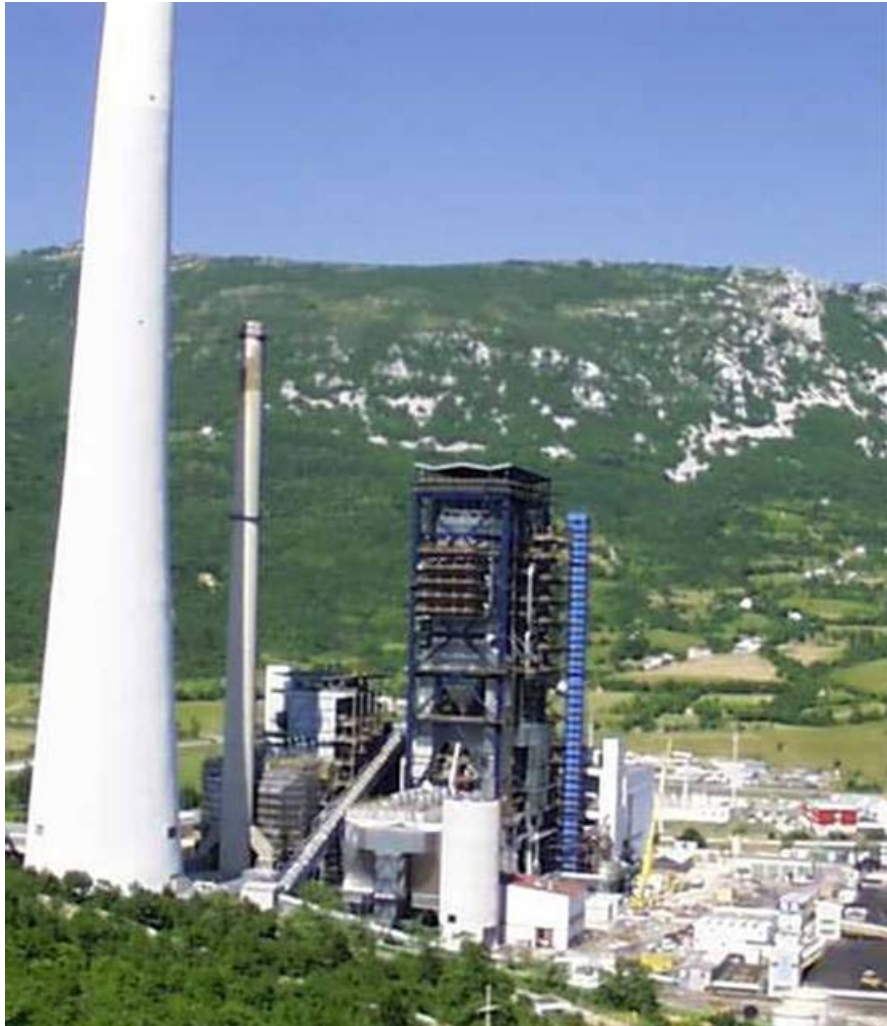
Slika 1.7 Termoelektrana "Plomin II"
