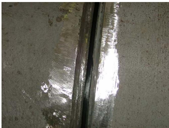
Slika 4.9 Pripremljeni žlijeb za zavarivanje "U" zavarom
