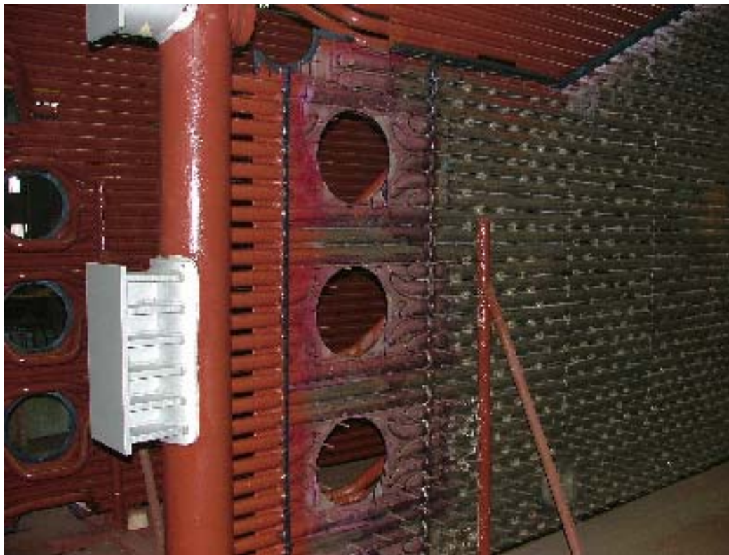
Slika 4.6 Otvori na membranskom zidu
