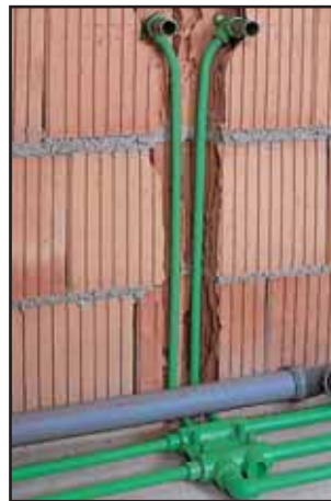
Instalacija pod žbuku
