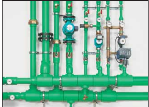
Izvedba razdjelnika grijanja
