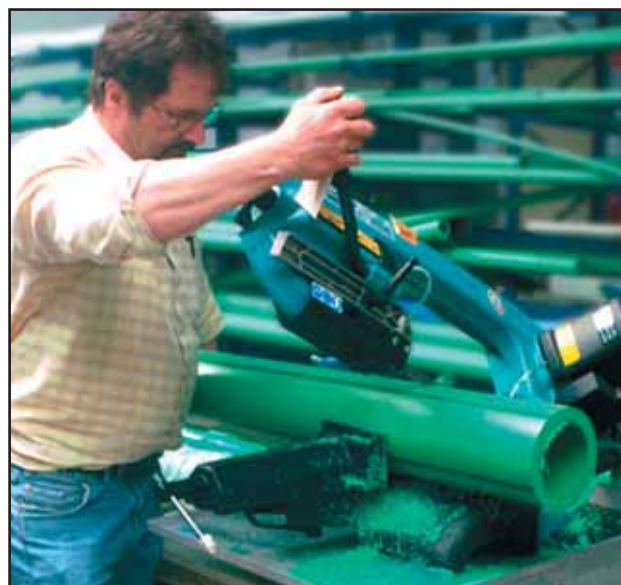
Prije postupka zavarivanja će se 160-cijev izmjeriti na željenu dužinu
