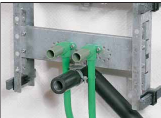
Instalacija na zid
