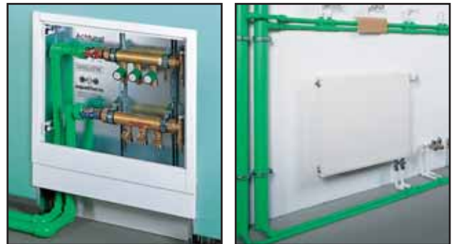
U sektoru grijanja se također ugrađuje priključak sustava podnog grijanja ili instalacija prstenastih vodova grijaćih tijela sve do slavine s Fusiotherm ®-om.
