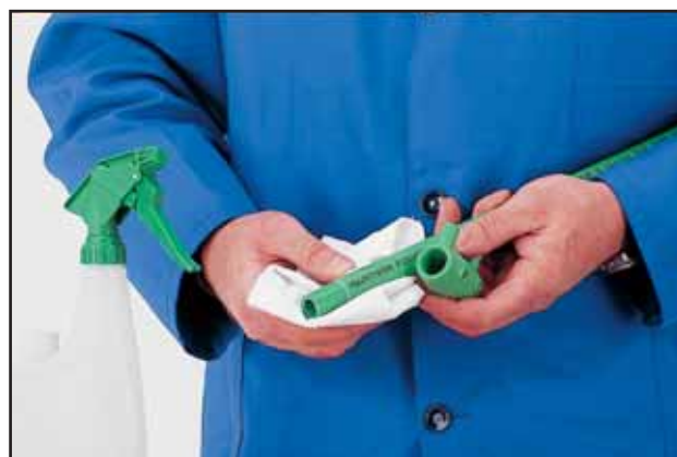
Čišćenje unutarnje površine spojnice
