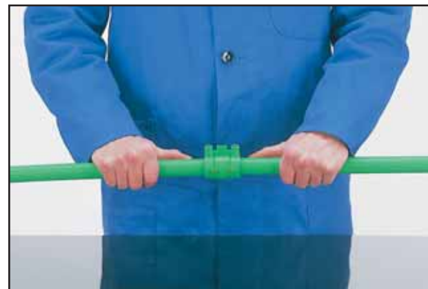
Uvlačenje u električnu spojnicu
