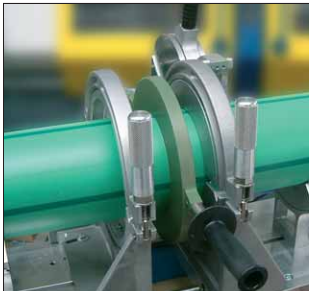
Elementi za zavarivanje se postavljaju u poziciju za zavarivanje.
