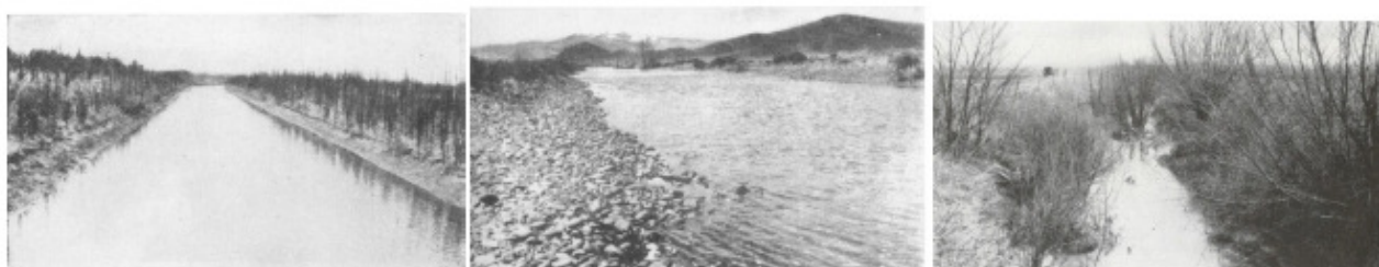
Slika 9.13 – karakteristične vrijednosti Manning-ovog koeficijenta hrapavosti n (lijevo – grubi betonski kanal n = 0,02 ; sredina – šljunkoviti korito aluvijalnog vodotoka n = 0,03 ; desno – intenzivno zatravnjeni kanal n = 0,08 (Chow, 1959)
