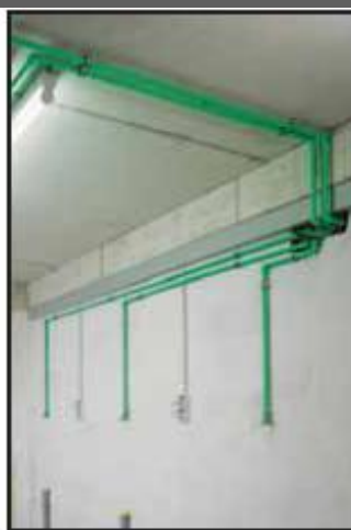
Instalacija na žbuku
