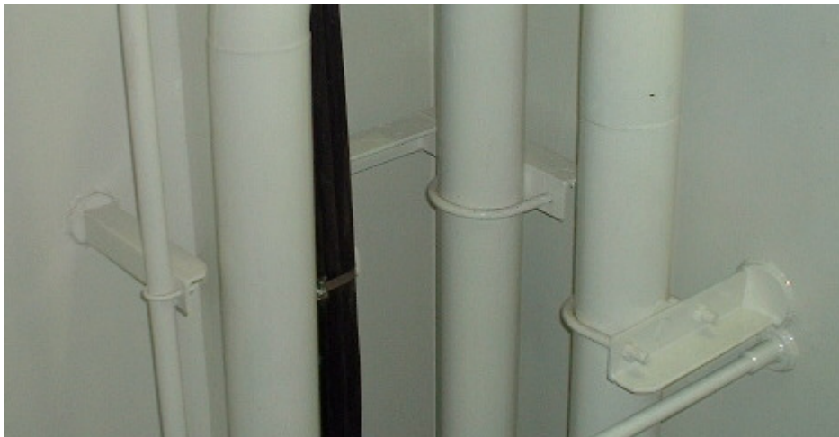
Slika xxx. Detalj montaže nosača cijevi
