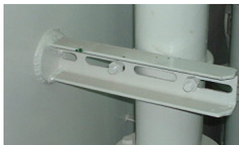
Slika xxx. Detalj montaže perforiranih nosača cijevi
