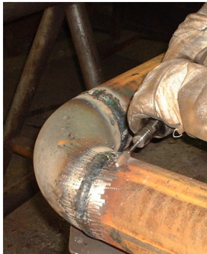
Slika xxx. Brušenje zavarenog cijevnog luka
