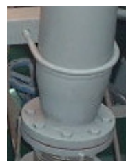
Slika xxx. Detalj redukcije na obrađenoj cijevi
