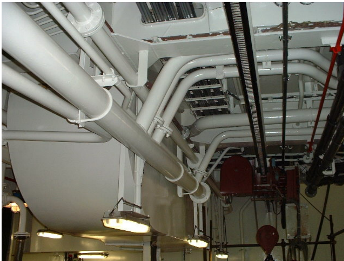
Slika xxx. Detalj smještaja cjevovoda u strojarnici
