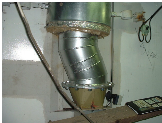
Slika xxx. Detalj ispušnog cjevovod izrađen iz cijevnih segmenata
