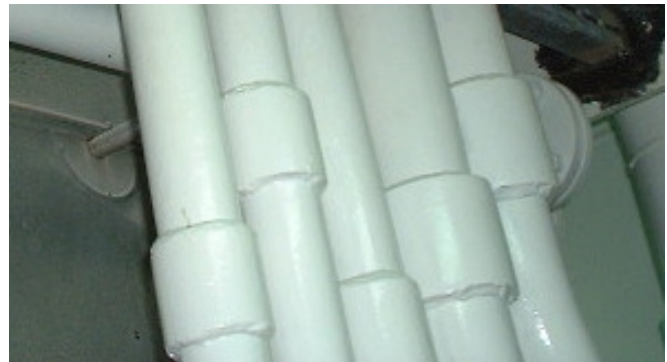
Slika xxx. Spajanje čeličnih cijevi s cijevnim spojnica
