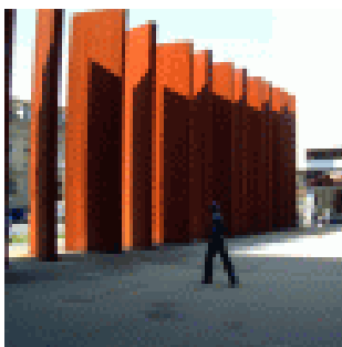
Spomenik paalima u ratu u Osijeku – primjer korozije u umjetnosti
