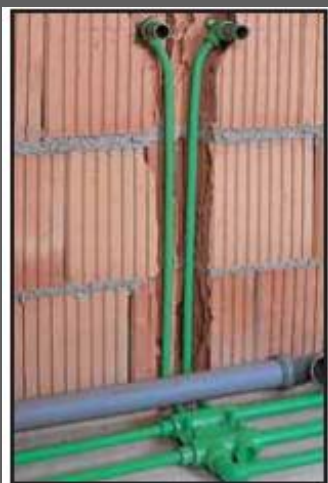
Instalacija pod žbuku
