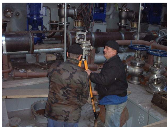
Slika xxx. Podizanje mete u strojarnici prema proračunu elastične linije osovinskog voda
