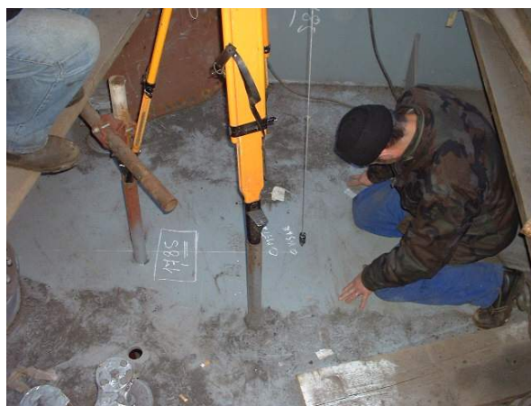
Slika xxx. Određivanje položaja krajnje točke na temeljnoj ploči glavnog motora
