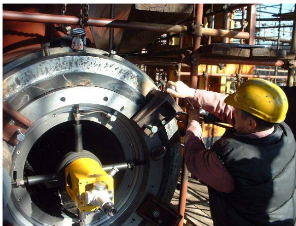
Slika xxx. Centriranje ležajeva na novu poziciju prema proračunu elastične linije osovinskog voda
