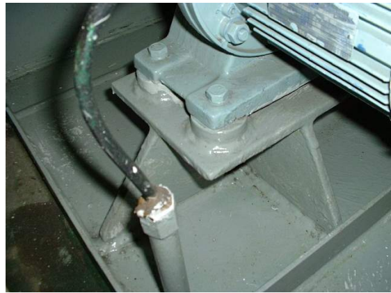
Slika xxx. Detalj postavljanja okruglih pločica za uklinjenje strojeva i uređaja
