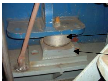
Slika xxx. Smještaj dizelskih-električnih generatora s detaljem njihova utemeljenja
