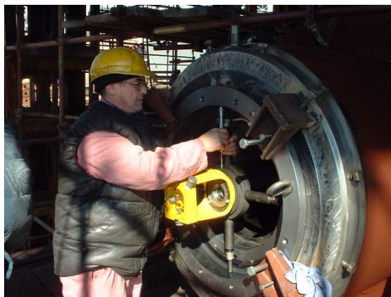
Slika xxx. Postavljanje mete u centar stražnjeg ležaja
